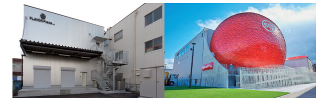
工場・プラント
